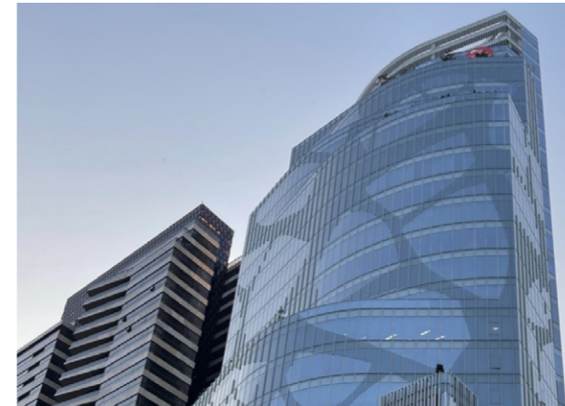
中信金控台中金融大樓 CTBC Taichung HQ Low-E(TTE60A/TSE45)網印複層玻璃
