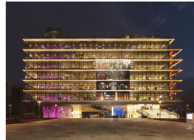
高雄市立圖書館總館 Kaohsiung Main Public Library Low-E (TDE60) 複層玻璃
