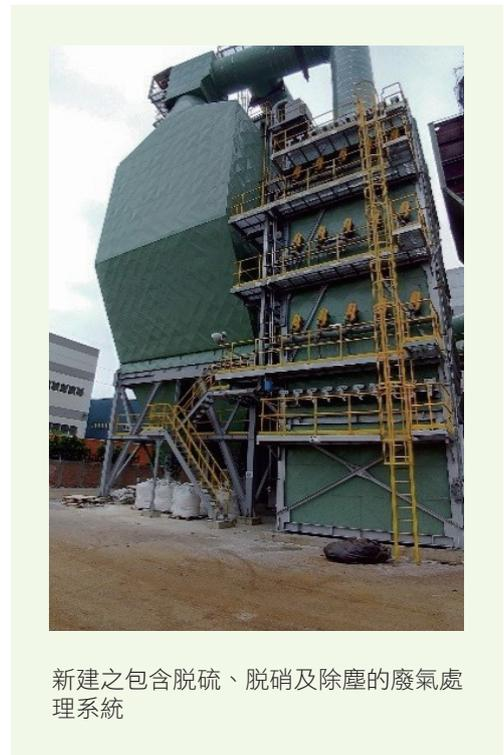
新建之包含脫硫、脫硝及除塵的廢氣處理系統
