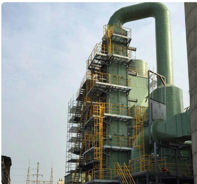
台中廠新建廢氣脫硫脫硝處理設備
