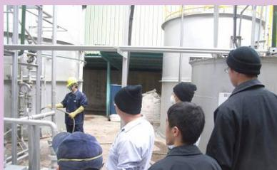
NaOH洩漏沖水稀釋處理
