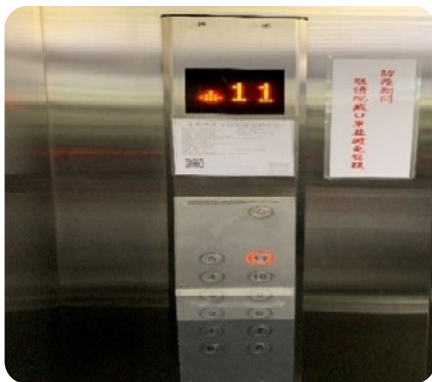
設置電梯按鈕隔絕墊
