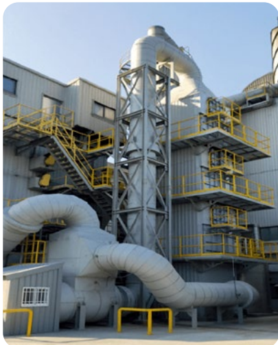
TS-3 SCR 脫硝設備
