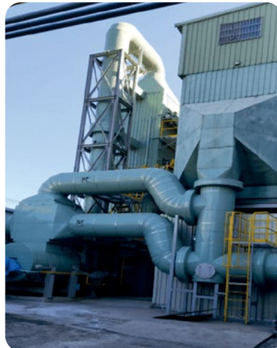
TS-7 SCR 脫硝設備
